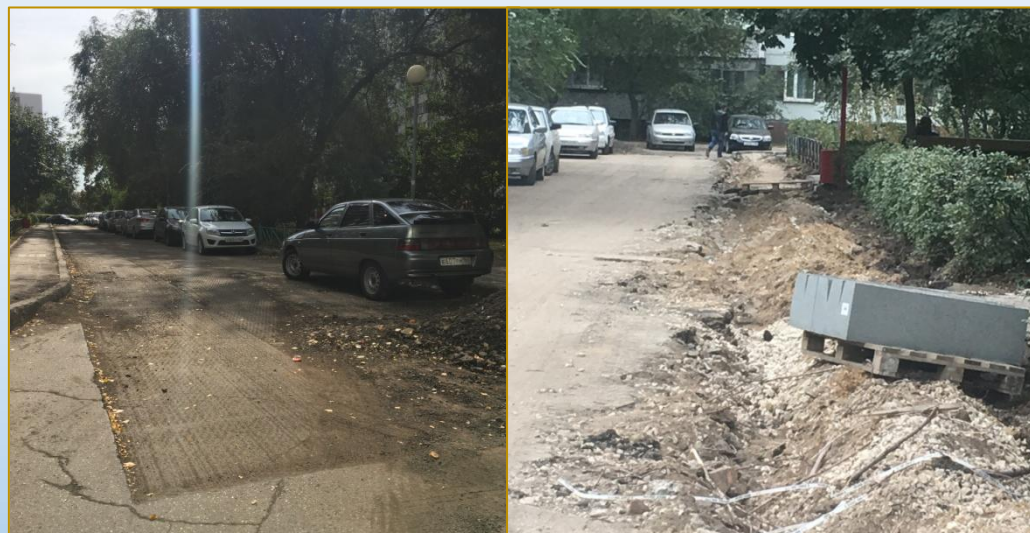
Фото объекта «В работе»
