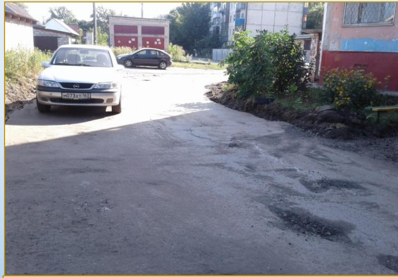
Фото объекта «В работе»
