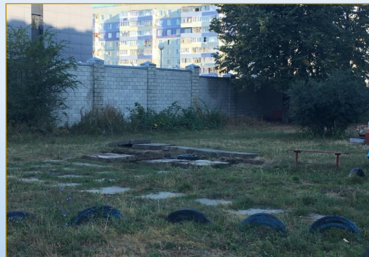
Фото объекта «В работе»
