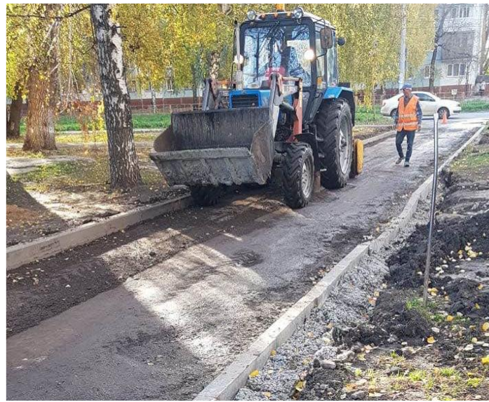
Фото объекта «В работе»
