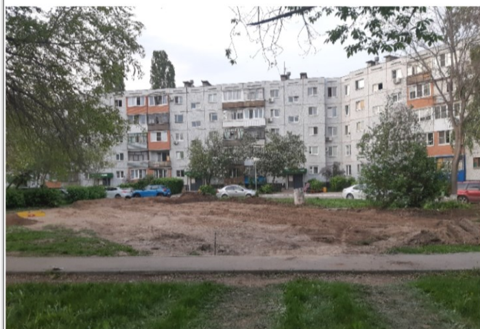
Фото объекта «В работе»
