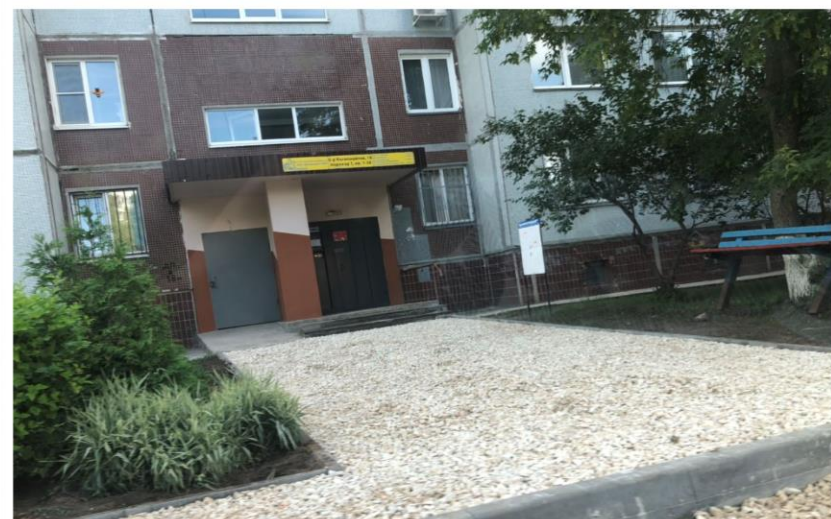
Фото объекта «В работе»
