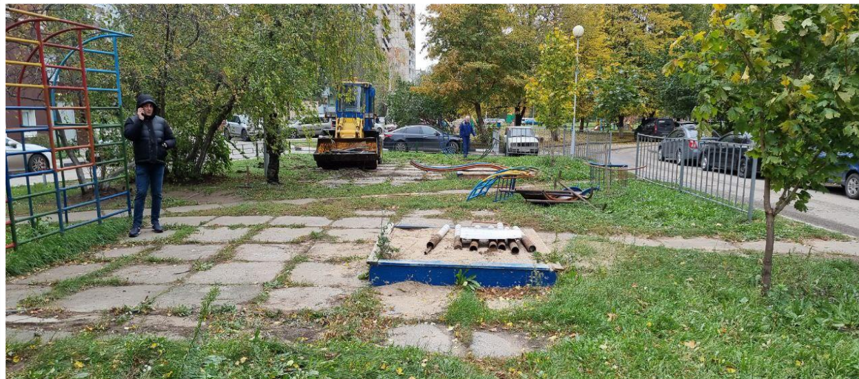
Фото объекта «В работе»
