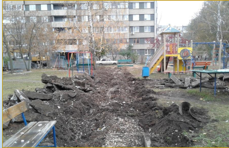
Фото объекта «В работе»
