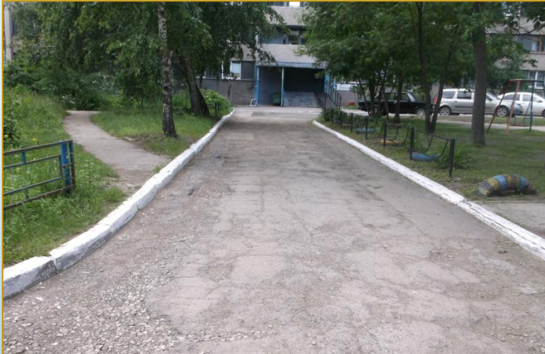
Фото объекта «До»
