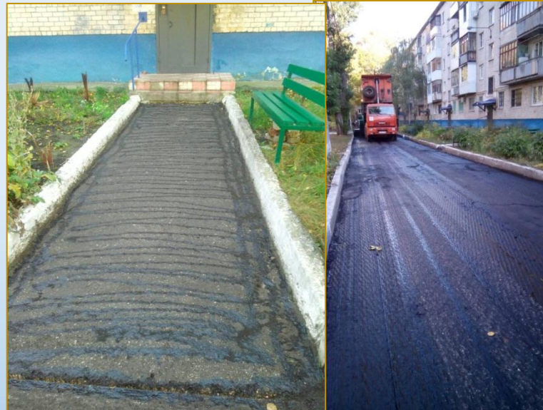
Фото объекта «В работе»
