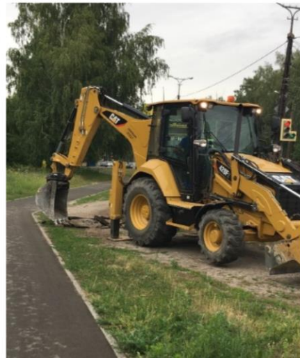
Фото объекта «В работе»
