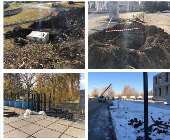
Фото объекта «В работе»
