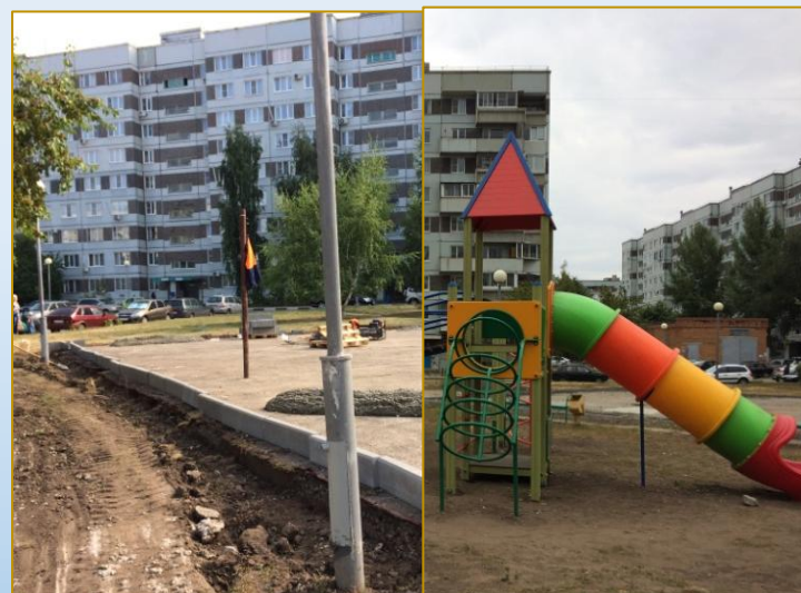
Фото объекта «В работе»
