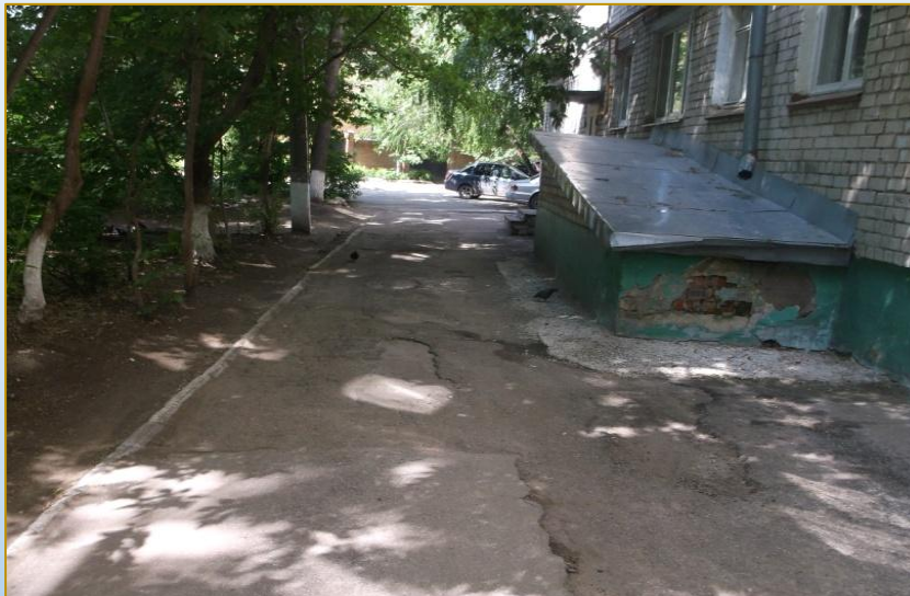
Фото объекта «До»
