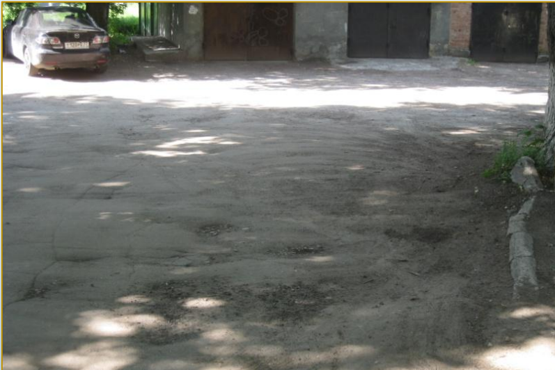
Фото объекта «До»
