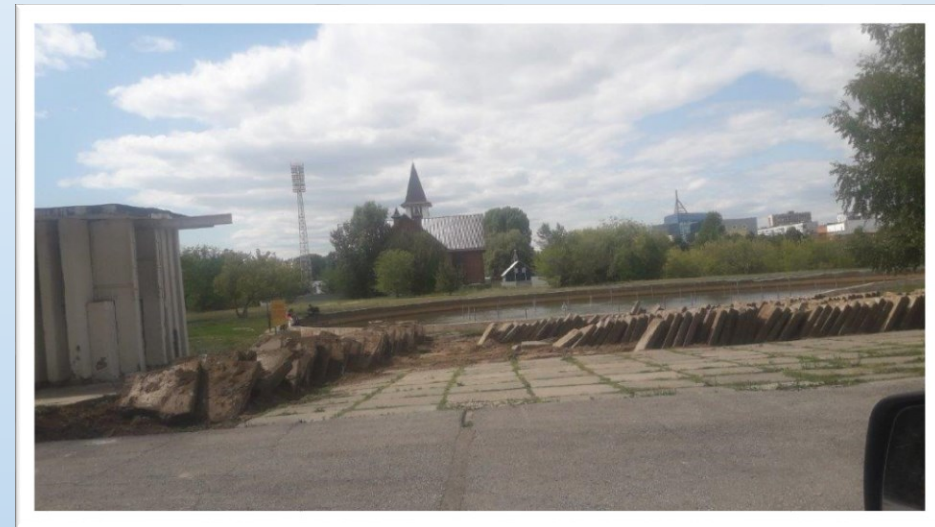
Фото объекта «В работе»
