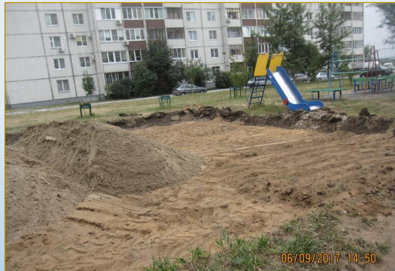
Фото объекта «В работе»
