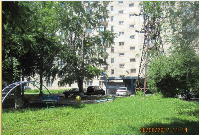
Фото объекта «До»
