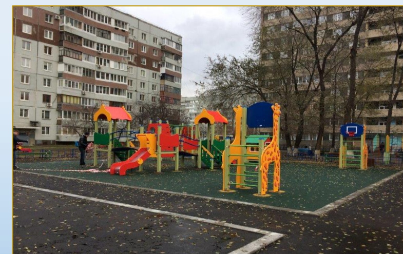
Фото объекта «После»
