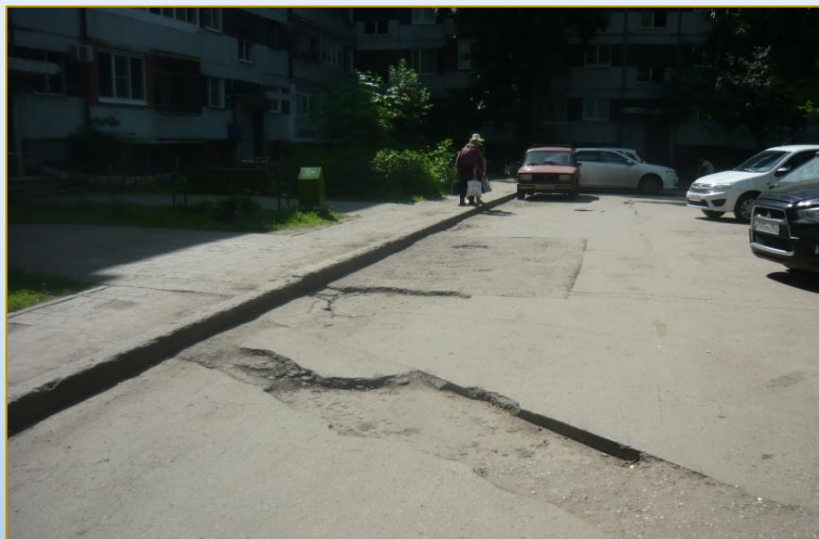
Фото объекта «До»
