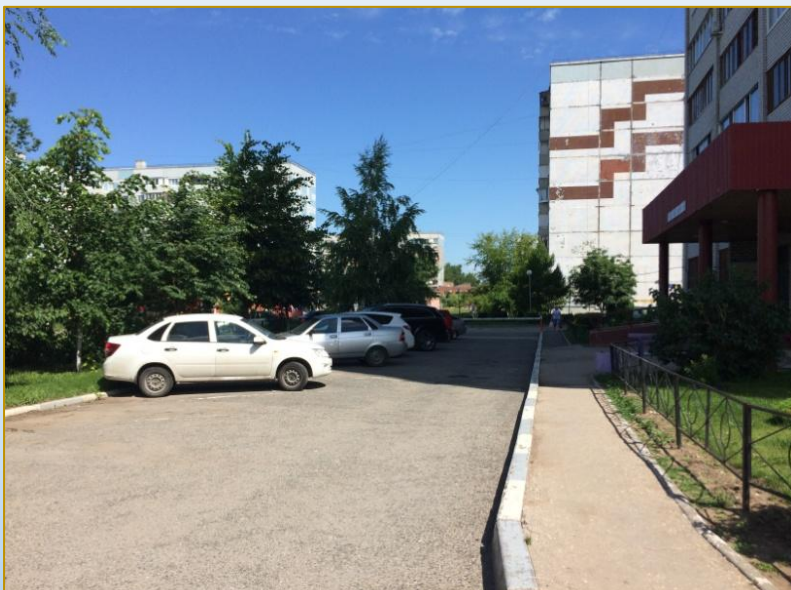
Фото объекта «До»
