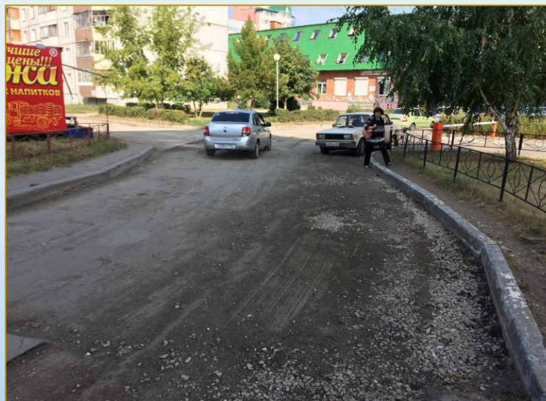
Фото объекта «В работе»
