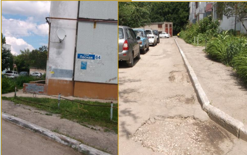
Фото объекта «До»
