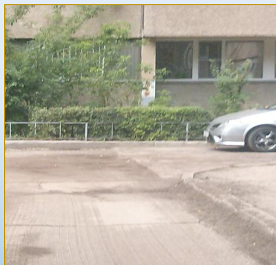
Фото объекта «В работе»
