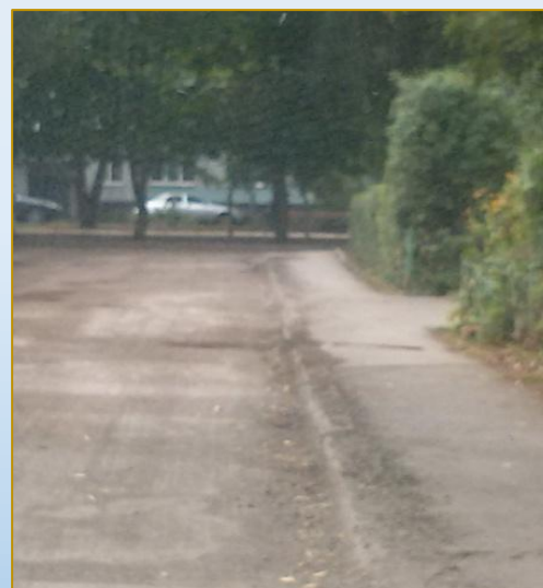
Фото объекта «В работе»
