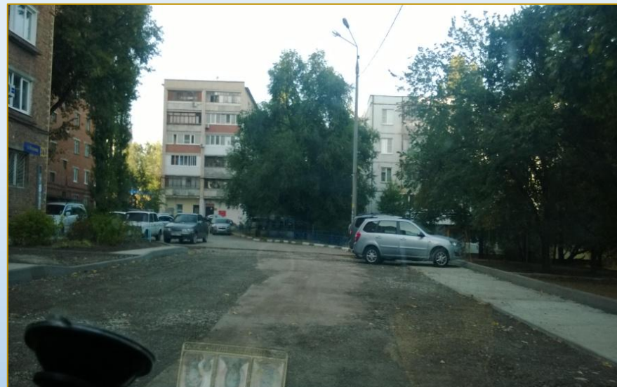
Фото объекта «В работе»
