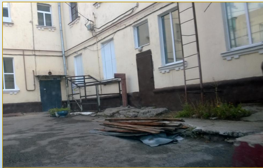
Фото объекта «В работе»
