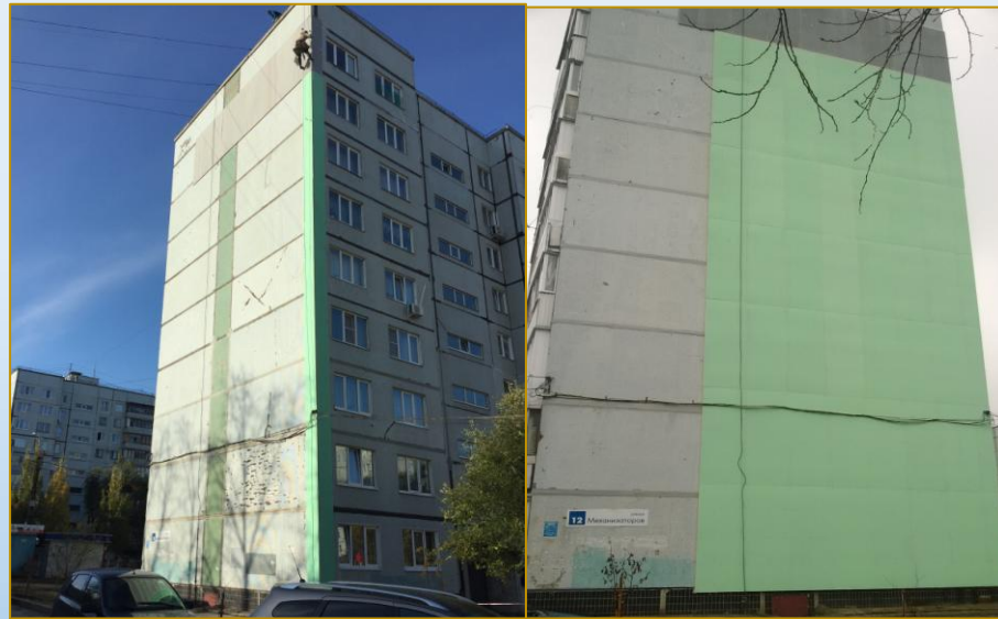
Фото объекта «В работе»
