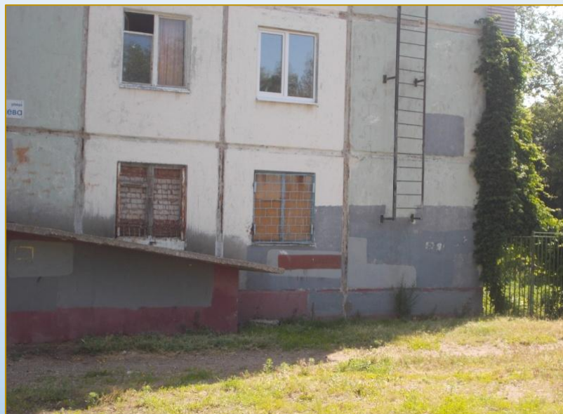
Фото объекта «До»
