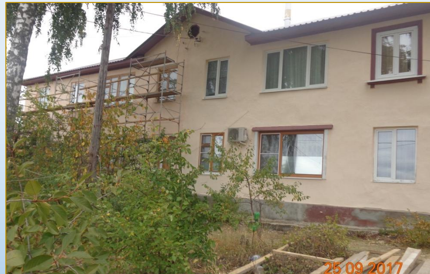
Фото объекта «В работе»
