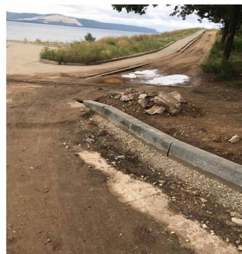
Фото объекта «В работе»
