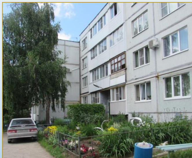
Фото объекта «До»
