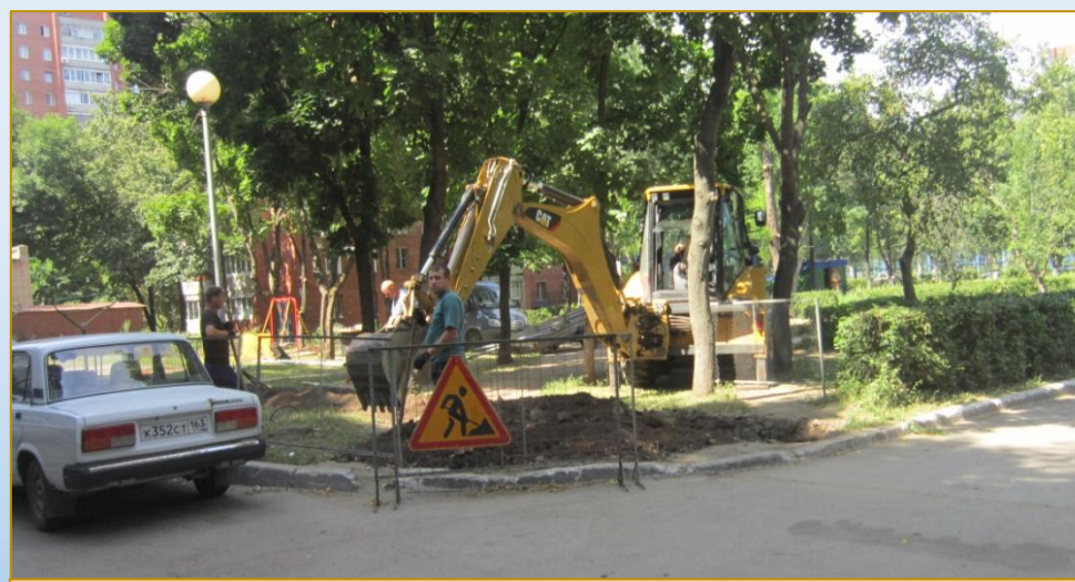
Фото объекта «В работе»
