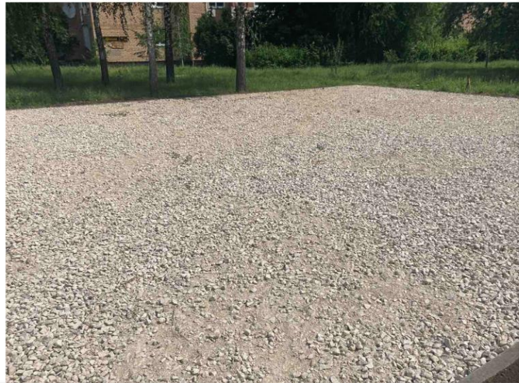
Фото объекта «В работе»
