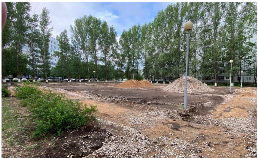
Фото объекта «В работе»
