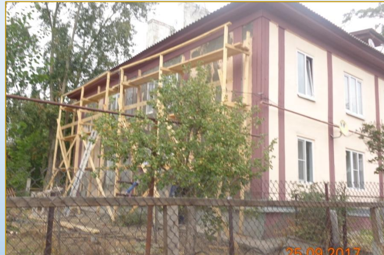
Фото объекта «В работе»
