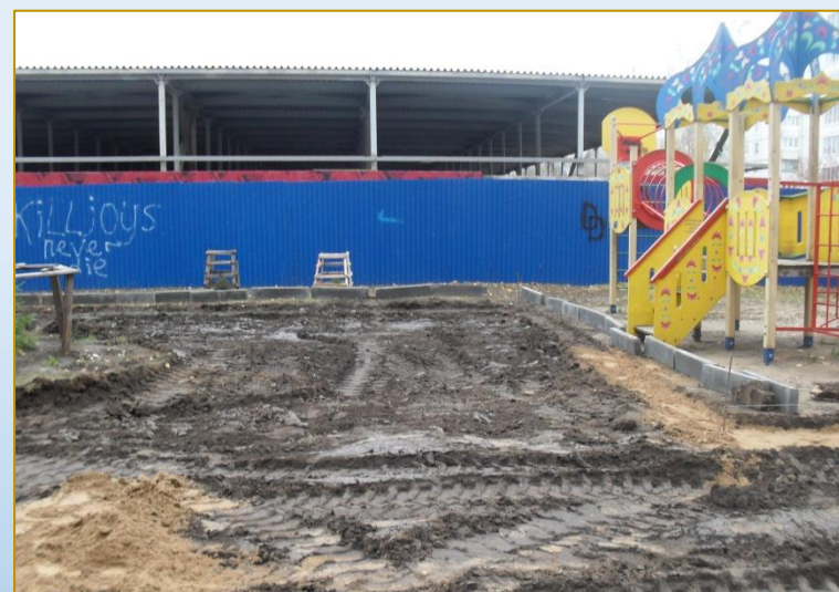
Фото объекта «В работе»
