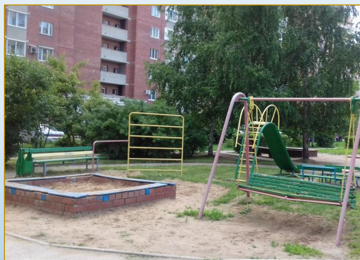
Фото объекта «До»
