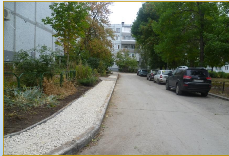
Фото объекта «В работе»
