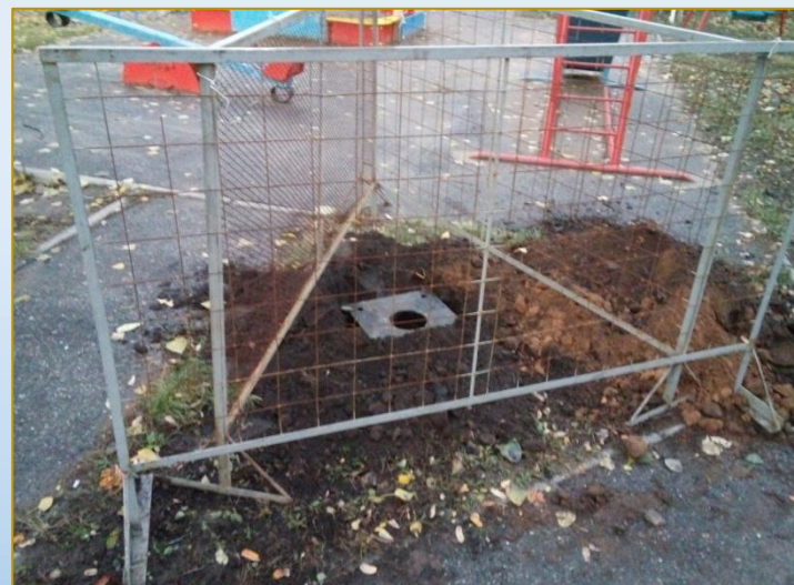
Фото объекта «В работе»
