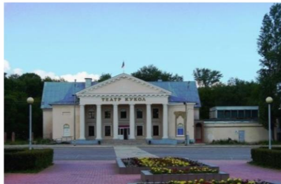
Фото объекта «До»
