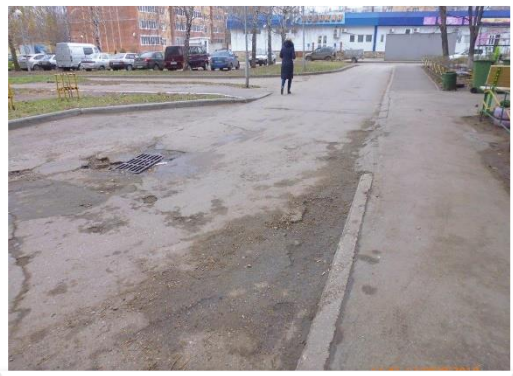
Фото объекта «До»
