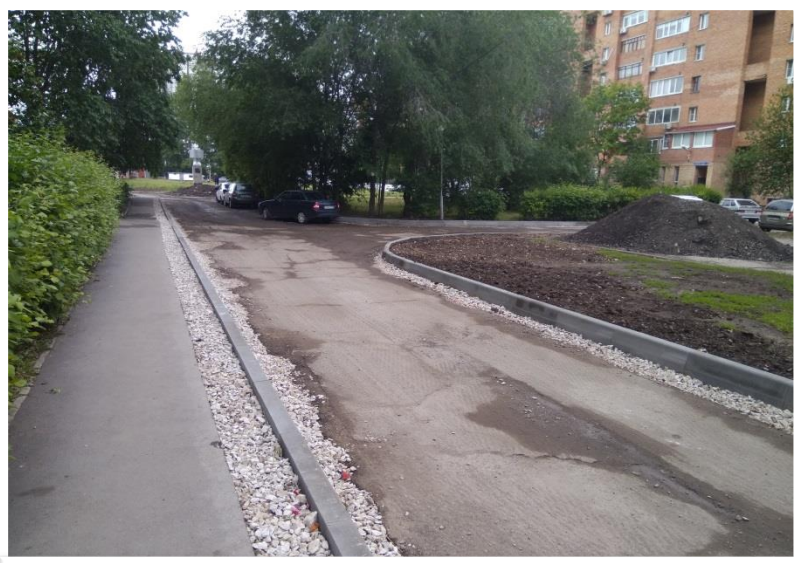
Фото объекта «В работе»
