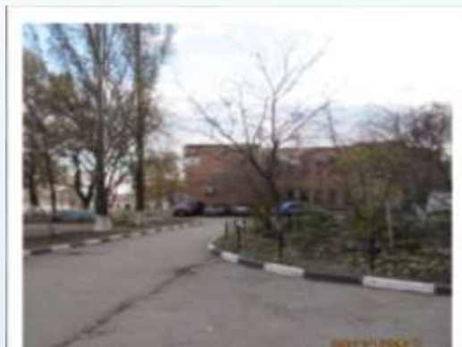
Фото объекта «До»
