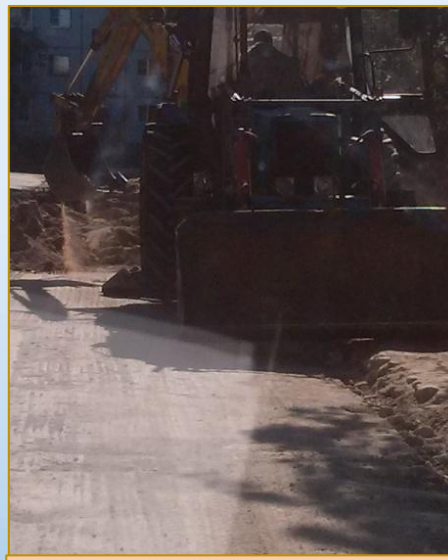
Фото объекта «В работе»
