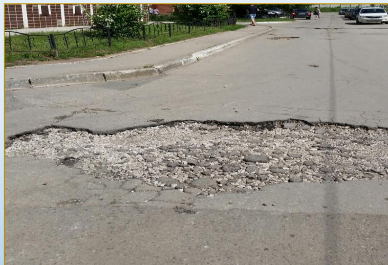
Фото объекта «До»
