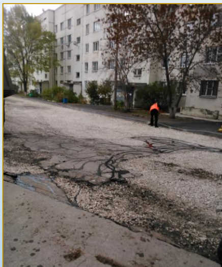
Фото объекта «До»
