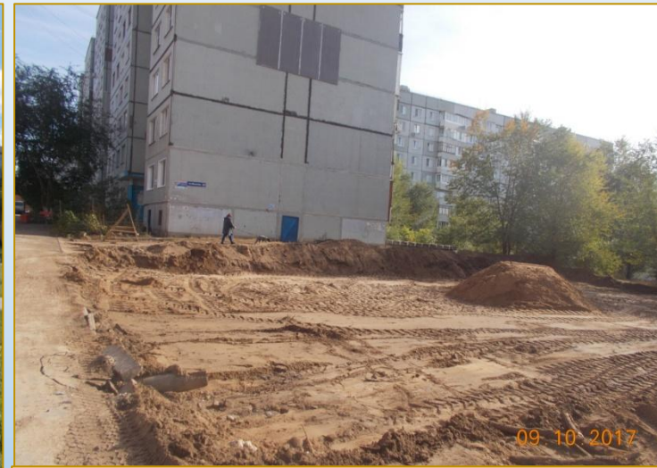
Фото объекта «В работе»
