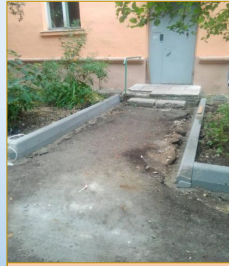
Фото объекта «В работе»
