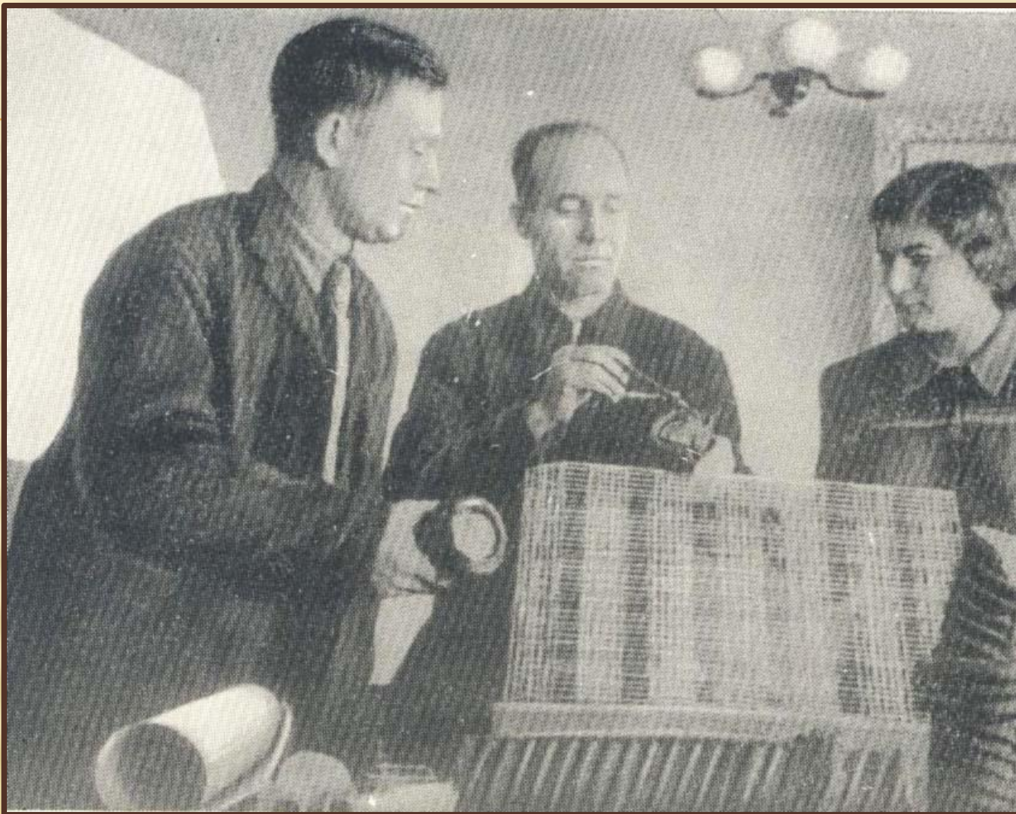
А.А. Улесов у арматурной конструкции
