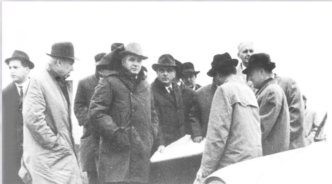
На строительной площадке ВАЗа. Слева направо: Б. С. Кашунин, Н.Ф. Семизоров, 2-й справа В.Н. Поляков.
