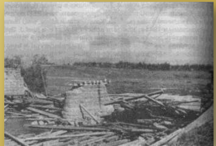
Взорванный мост через р. Прут.
