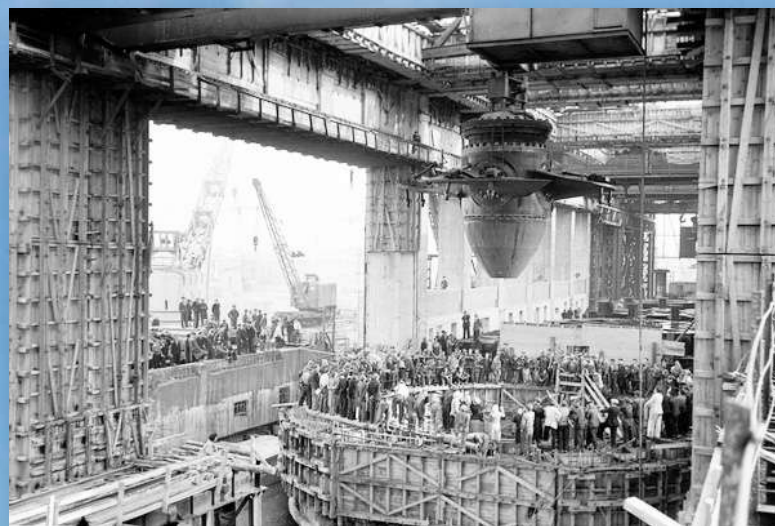
Монтаж турбин
