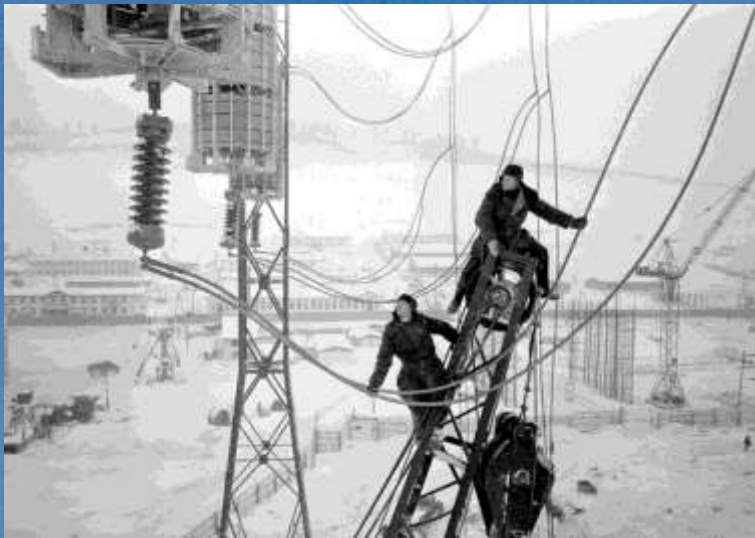
Работа по монтажу линии электропередач
