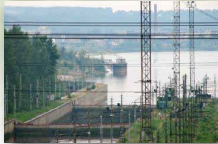
Шлюзы Камской ГЭС
